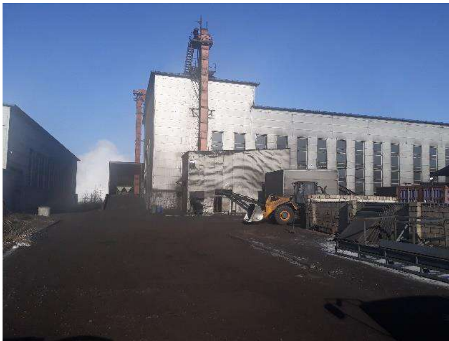
Зураг 63. Үйлдвэрийн нүүрсний тэжээлийн бункерийг битүүмжилсэн байдал
